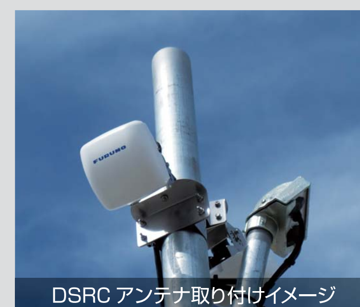
DSRC アンテナ取り付けイメージ
